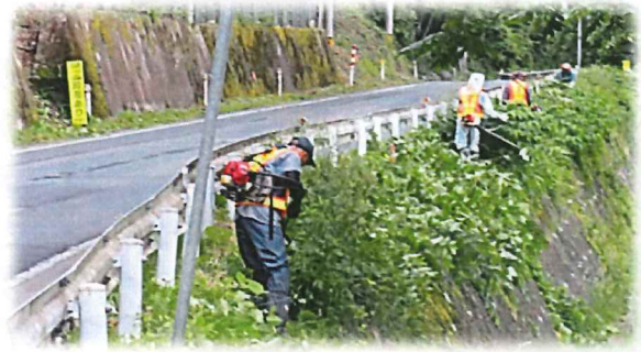
岩溪の草刈り作業中の様子
